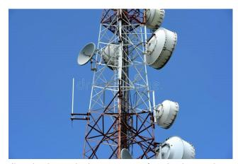
Diseño de la red de transmisión de los enlaces de microondas de "back-haul" del proyecto de tecnología iDEN 2G de Nextel. Este proyecto consistió en el cálculo de los enlaces, la estimación presupuestaria del proyecto, la identificación de sitios y la elaboración de especificaciones para la compra de los equipos y para los contratistas que los instalarían.
